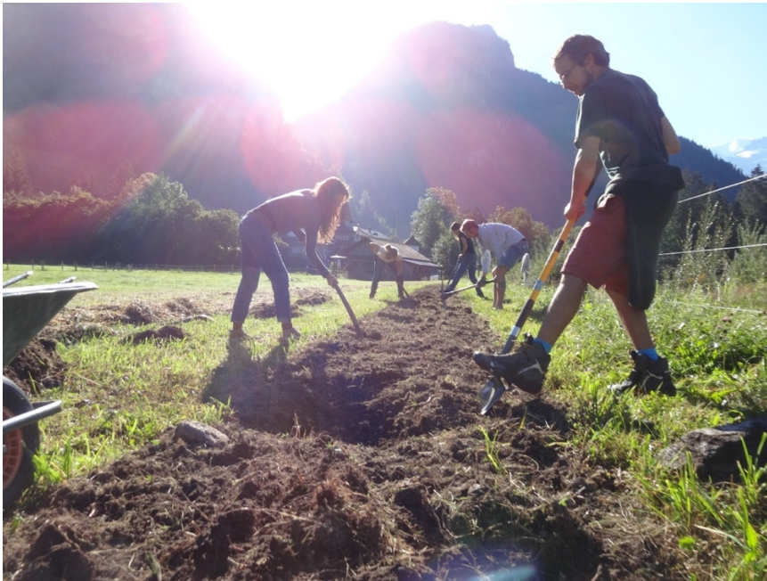
Abbildung 6 Montagmorgen Programm Fricker-Graben-Damm System anlegen
