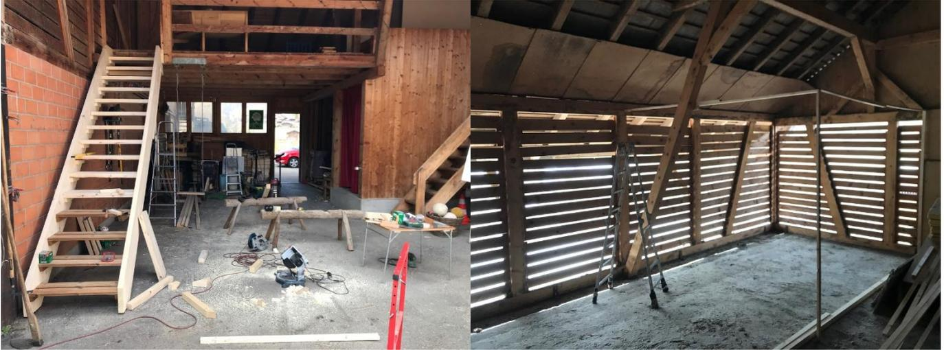
Abbildung 15 Bau der Zugangstreppe zum Kräuterraum, Bau des Raumes in den bestehenden Heustock
